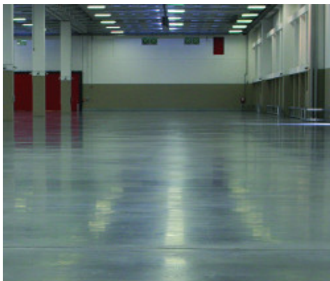
Παράδειγμα βιομηχανικού δαπέδου από σκυρόδεμα με προσθήκη Mapefibre NS12
