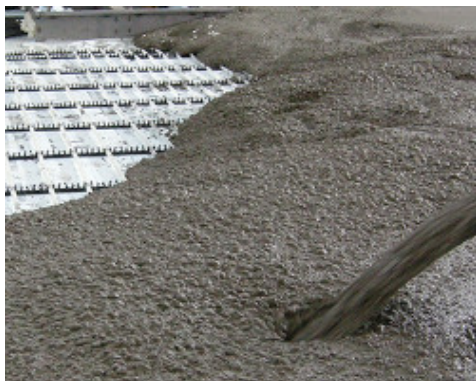
Σκυροδέτηση με προσθήκη Mapefibre NS12 για την αντιμετώπιση της ρηγμάτωσης από πλαστική συρρίκνωση
