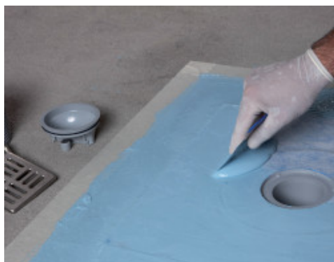
Εμποτισμός υφάσματος του ειδικού τεμαχίου Drain Vertical με το Mapelastic AquaDefense Zero
