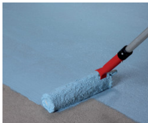
Εφαρμογή 1ης στρώσης Mapelastic Aquadefence Zero σε δάπεδο
