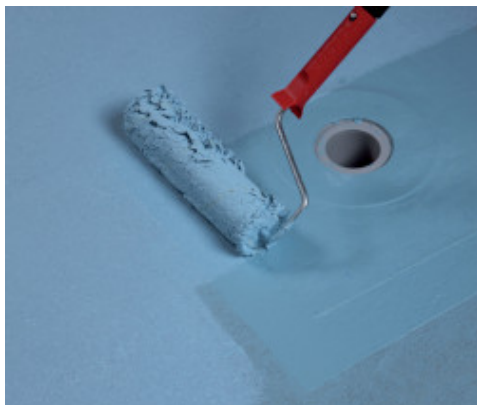
Εφαρμογή με ρολό 2ης στρώσης MApelastic AquaDefense Zero
