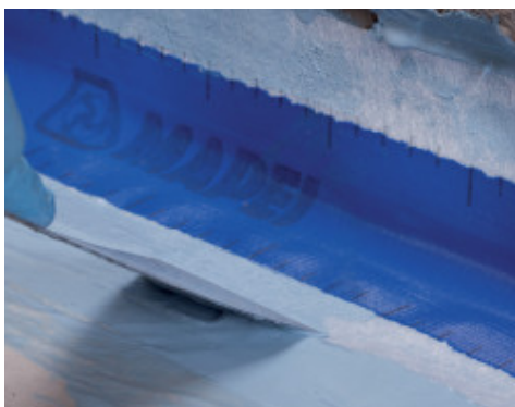
Εφαρμογή του Mapeband στα σημεία σύνδεσης τοίχου-δαπέδου με Mapelastic AquaDefense Zero
