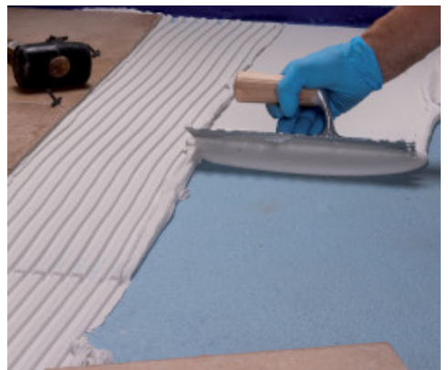
Κόλληση πλακιδίων πάνω στο Mapelastic AquaDefense Zero
