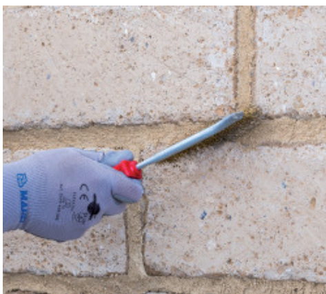
“Βούρτσισμα” των αρμών κονιάματος
