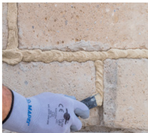
Απομάκρυνση πλεονάζοντος κονιάματος
