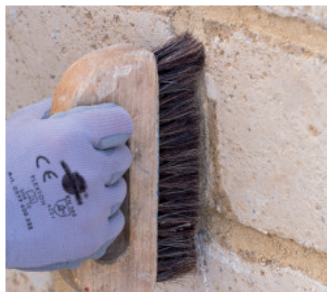
Φινίρισμα των αρμών κονιάματος
